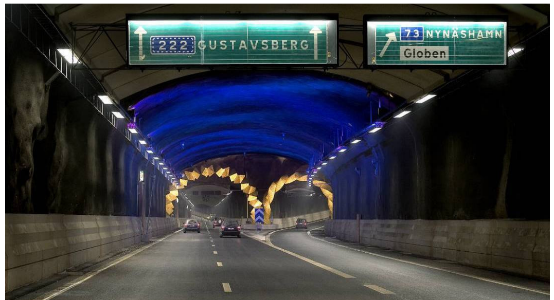
Figur 13: Underjordisk frakørselsrampe i tunnelkonstruktion, Södra Länken, Stockholm
